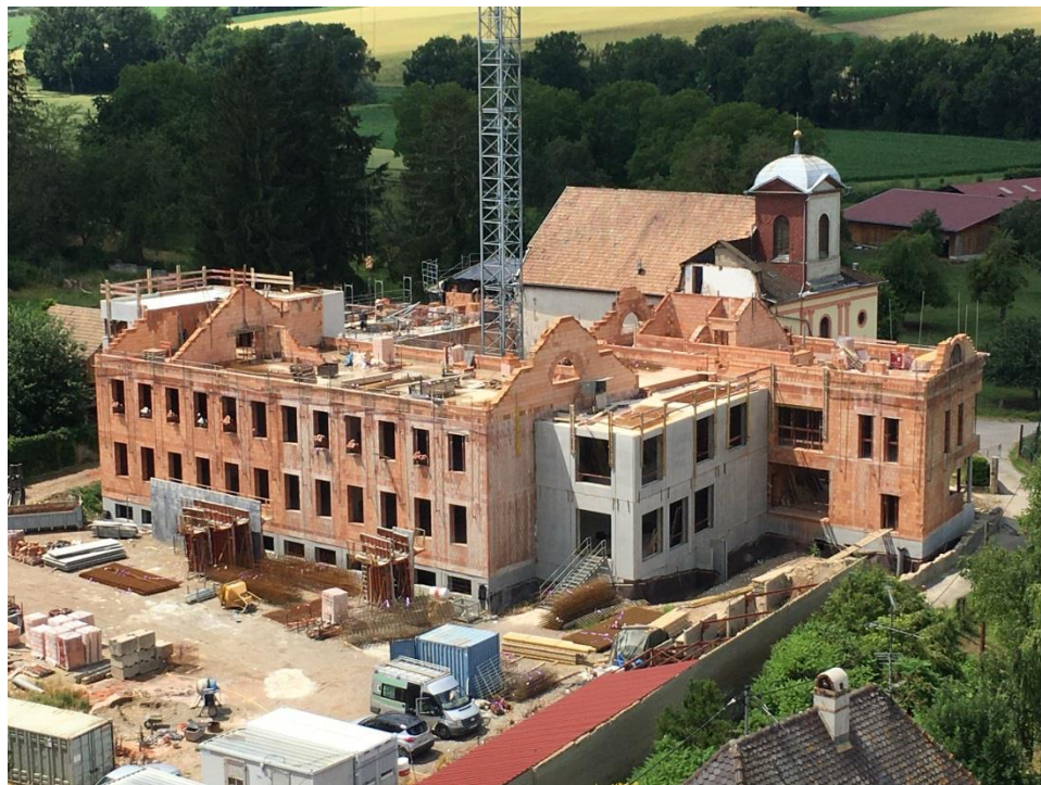
Photo du chantier prise le 28 juin 2021
